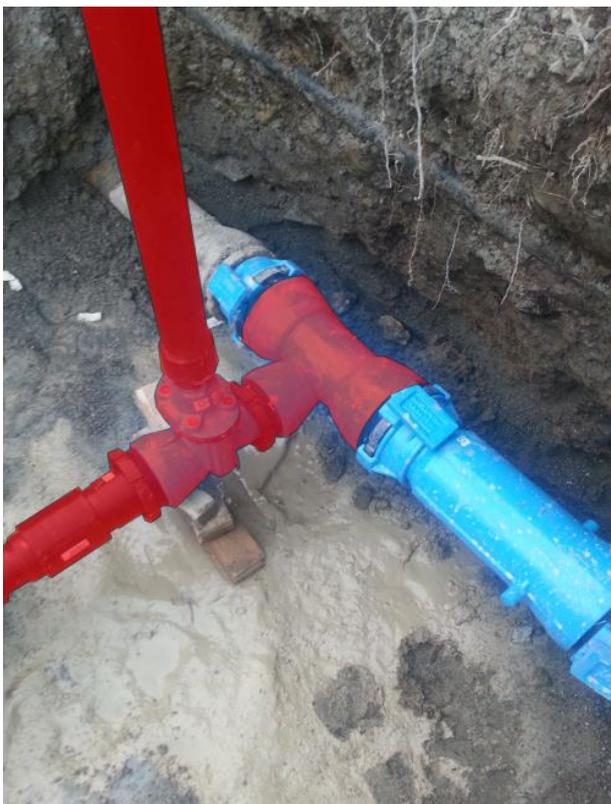
Abbildung 3: Abzweigstück mit Schieber
