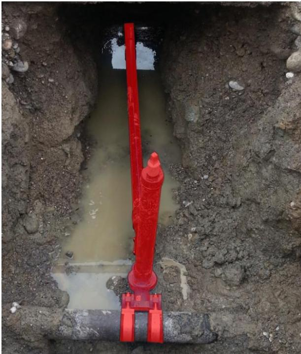
Abbildung 1: Anbohrschieber mit Hausanschlussleitung
