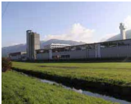
Abbildung 2.72: Freifläche auf der Nordseite
