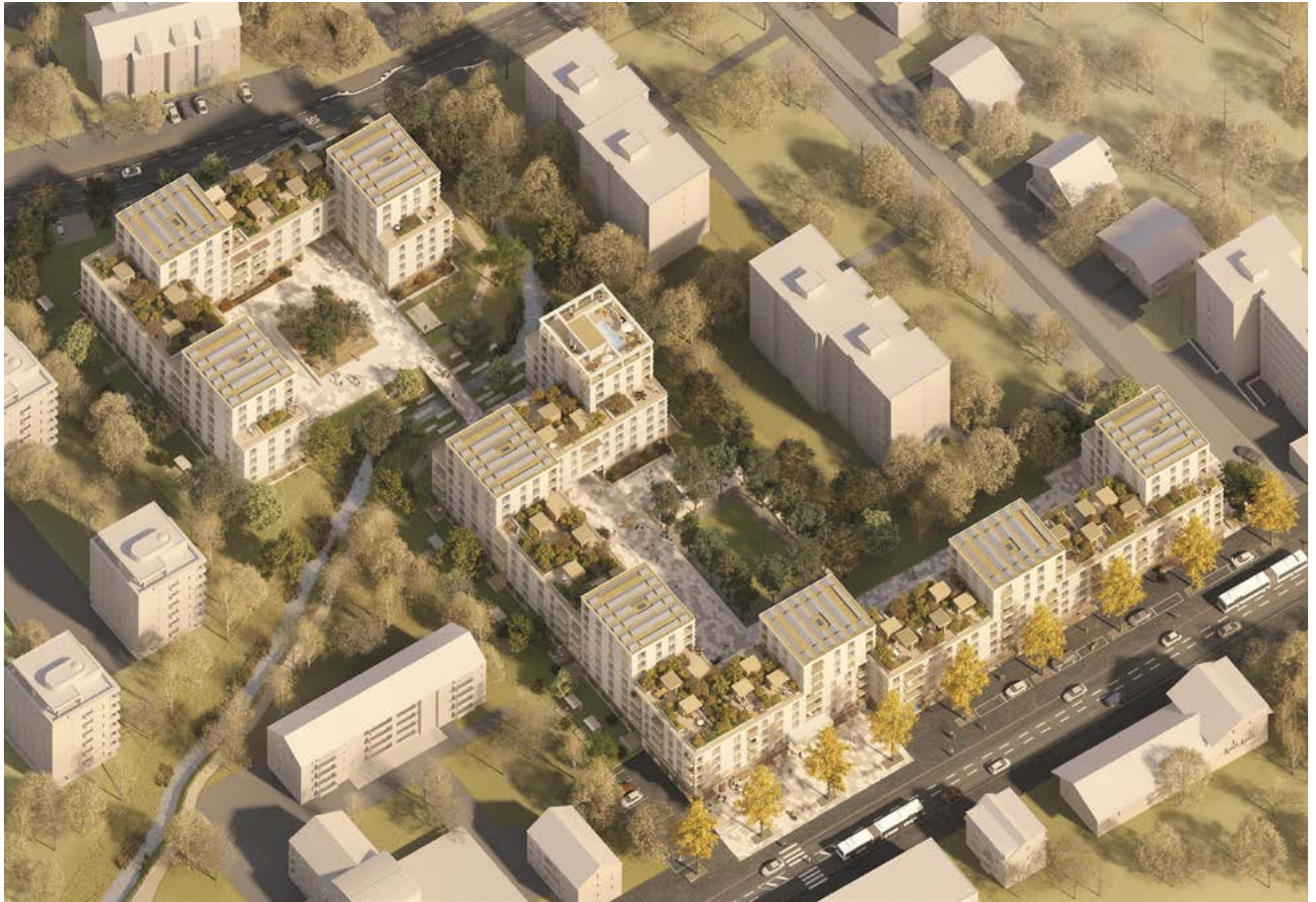
Abbildung 12: Direkt zugänglich begrünte Dachebene. Quelle: Gemeinde Ebikon
