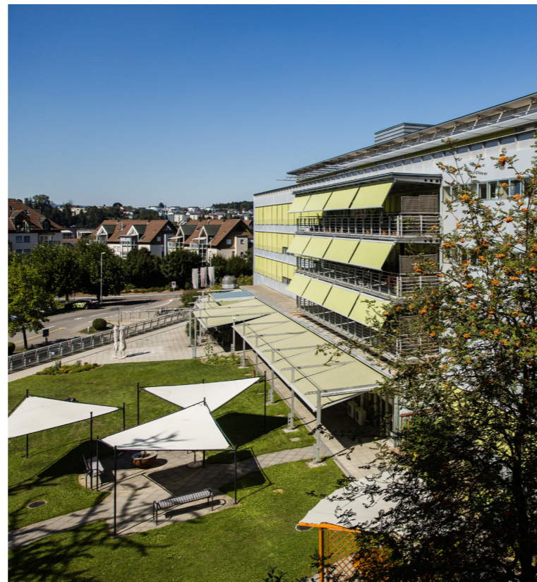
Das Zentrum Höchweid in Ebikon soll in den nächsten Jahren saniert und erweitert werden. Bild: Stefan Bohrer
