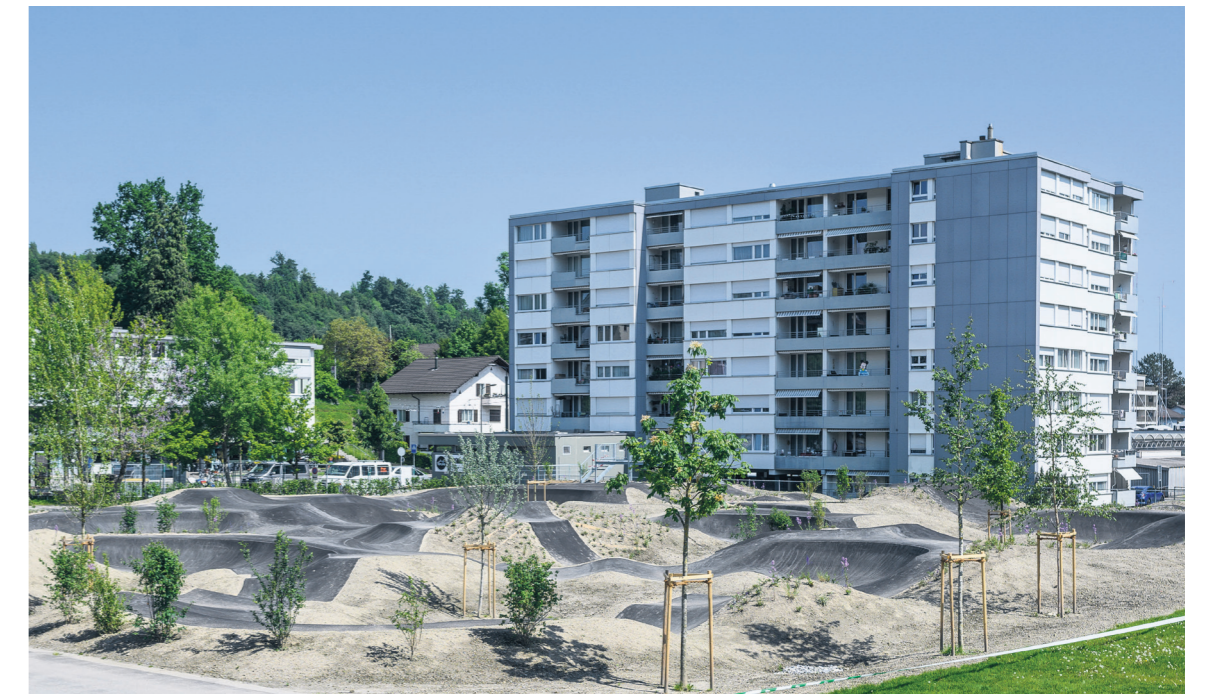
Inklusive Jumphline ist die Fahrbahn des Pumptracks gut 330 Meter lang.
