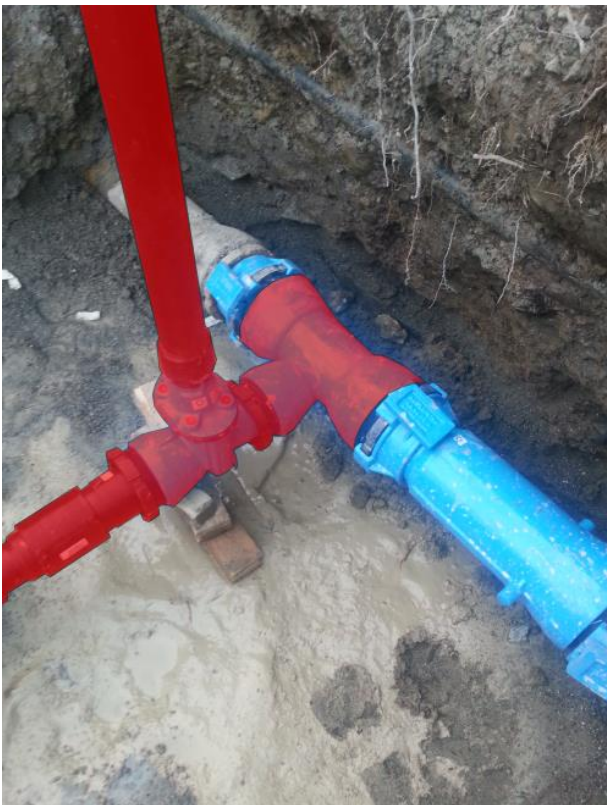
Abbildung 3: Abzweigstück mit Schieber
