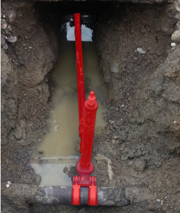
Abbildung 1: Anbohrschieber mit Hausanschlussleitung
