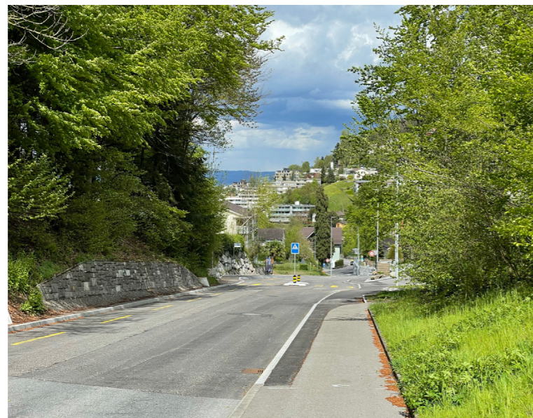
Neue Werkleitungen, neuer Strassenoberbau, breitere Troittoirs für Fussgänger und barrierefreie Bushaltestellen entlang der Schlösslistrasse. Mitte August 2021 folgt schliesslich der finale Deckbelag.
