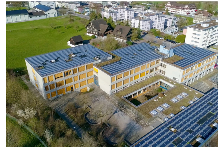
Luftaufnahme des Oberstufenschulhauses Wydenhof. Neben diesem Areal soll ein Campus entstehen.
